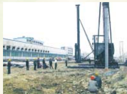
突貫工事の進む第3工場
