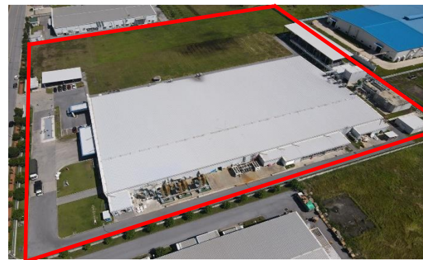
工場外観(全景)
